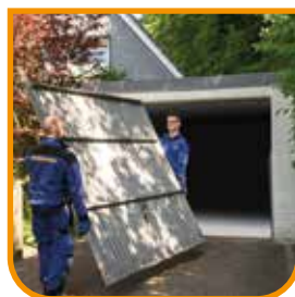
Demontaža i zbrinjavanje otpada
